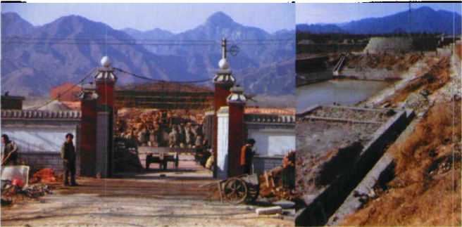
图4 建设中的南口畅心园
